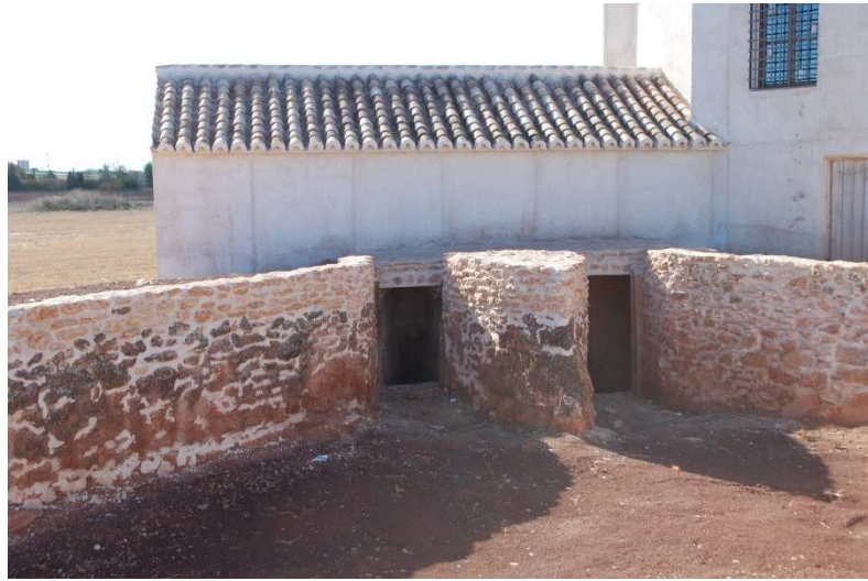
Localización del molino hidráulico o de verano y vista del extremo oriental de la balsa.
